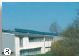
Blacy Panneaux solaires thermiques et pompe à chaleur aérothermique Vendredi 3 décembre à 14h30
