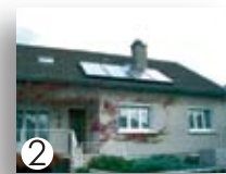
2 Chaumont Système solaire combiné Samedi 9 octobre à 14h
