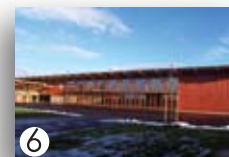
6 Fayl-Billot (Collège) Chaufferie bois Vendredi 5 novembre à 15h
